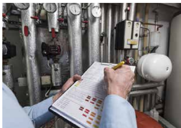
Gebäude-Check im Rahmen der Beratungskampagne. Foto: Energie- & Umweltzentrum Allgäu
